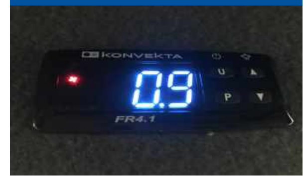
De installatie wordt vanuit de cabine bediend
