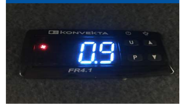
De installatie wordt vanuit de cabine bediend
